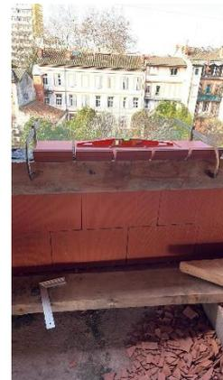
01/02/23 : « Nous étions quatre ouvriers sur le chantier habituel, prêts à l'ouvrage dès 8h30. Nous avons réalisé les joints des tablettes posées la veille. Les maçons français n'ont pas l'air de connaître le fer à joint, un outil pourtant très fréquemment utilisé en Belgique. Nous avons donc du remplir les espaces entre les pièces à l'aide d'une truelle.
